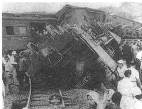
Y 福島県(東北本線松川駅付近)
